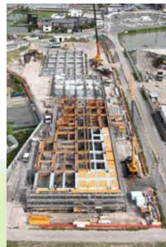
新特養建設現場
