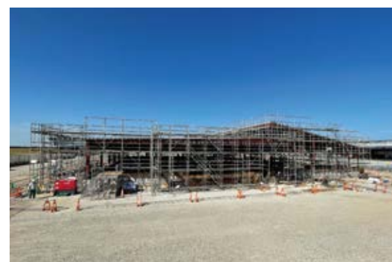
建設中の様子
